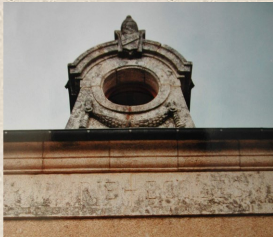
23 : l'oculus de la mairie de Domeyrot cliché de l'auteur
